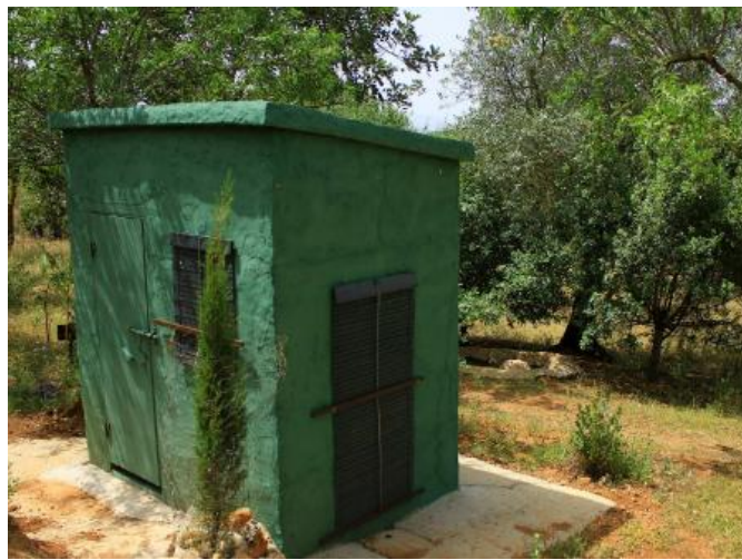
Ejemplo de caseta de bombeo adaptada como HIDE
